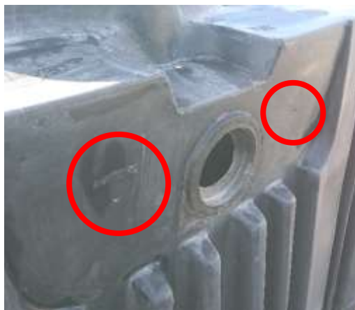
Fig-17 : Points de percement de la cuve R-90 pour ventilation
